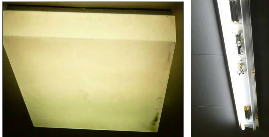
Abbildung 14: Leuchten in den Fluren und im Treppenhaus
