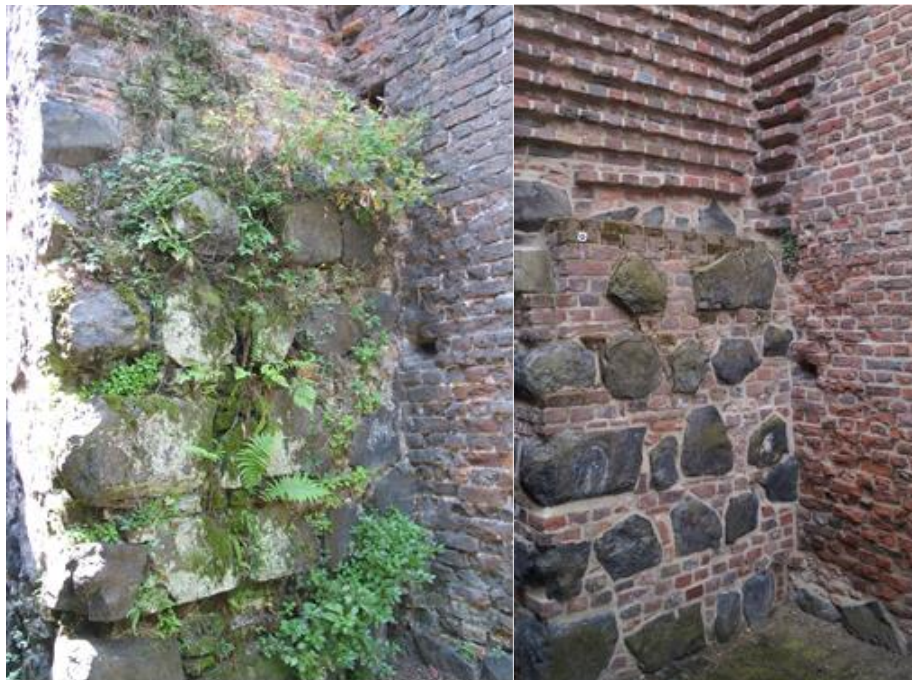
Abbildung 20: Nordexponierte Seite des Wachtürmchens an der Westmauer im Mai 2010 und „saubersanierter Neubau-Zustand“ nach der Sanierung 2021. (T. Braun)
