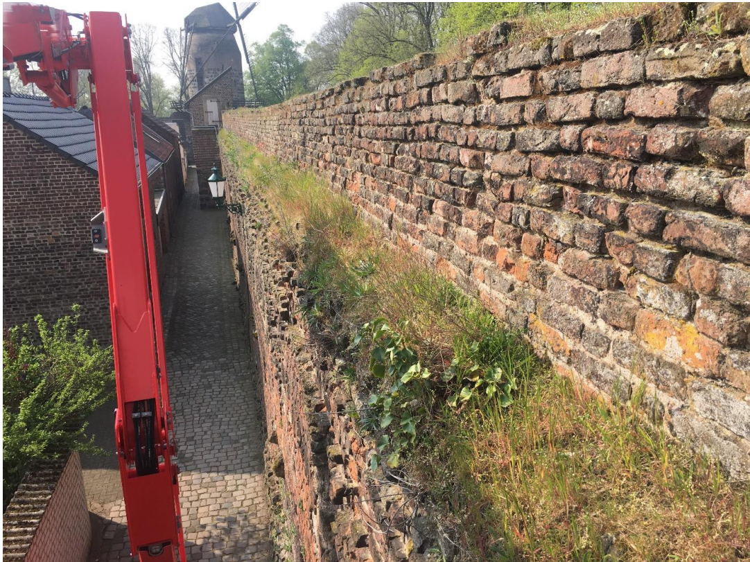
Abbildung 13: Auf der Mauerkrone und dem Sims (im Bild) hat sich ein bandförmiger Trockenbiotop entwickelt. (A. Dahl)
